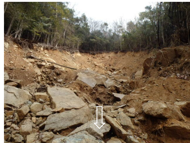
源頭部：不安定土砂が多量に残存
