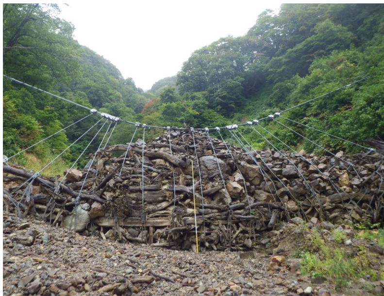
2回目土石流捕捉
