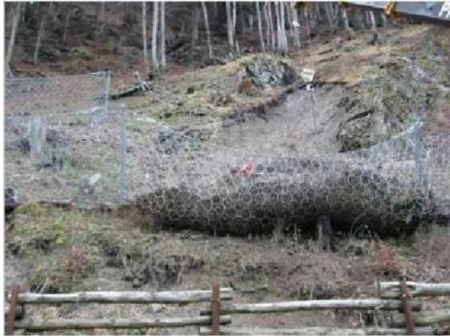
(1) 斜面崩壊土砂捕捉事例
