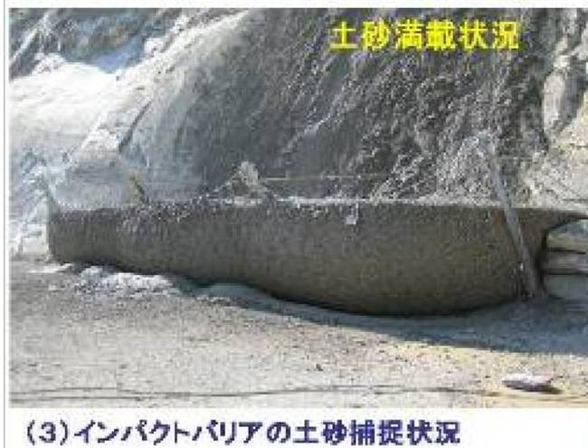
(3)インパクトバリアの土砂捕捉状況
