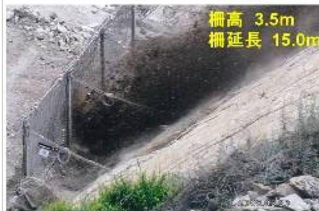
(2)インパクトバリアへの崩壊土砂落下状況
