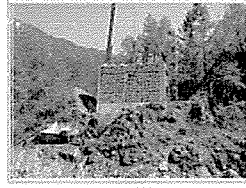
1. アンカレッジ設置
